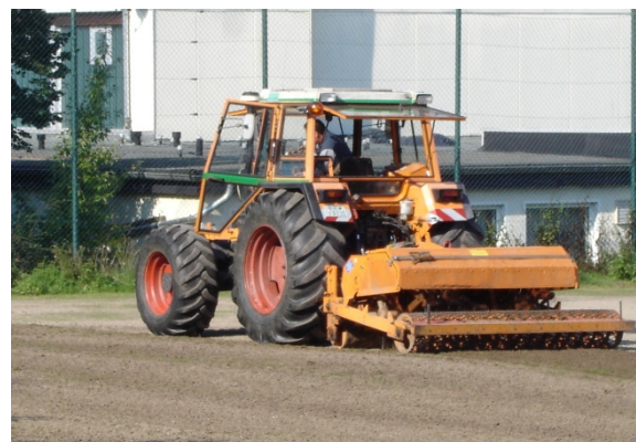
Renovationsmaßnahme Sportplatz Sack
