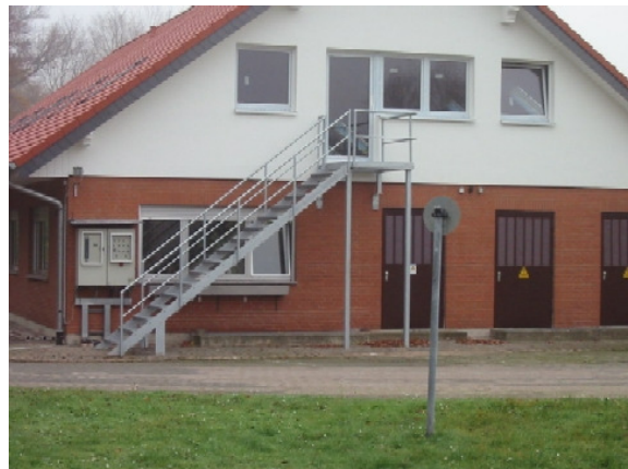
Neues Satteldach auf dem Betriebsgebäude
