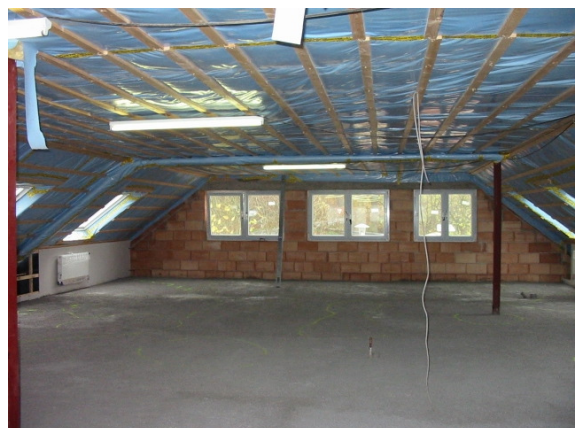
Dachausbau des Betriebsgebäudes
